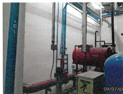
ถังสำรองน้ำใช้ เพื่อการดับเพลิง ชั้นดาดฟ้า
