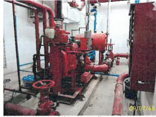
เครื่องสูบน้ำดับเพลิงชั้นตาดฟ้า
