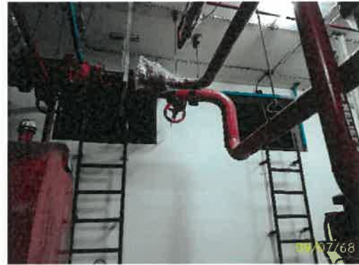
ถังสำรองน้ำใช้ เพื่อการดับเพลิง ชั้นใต้ดิน
